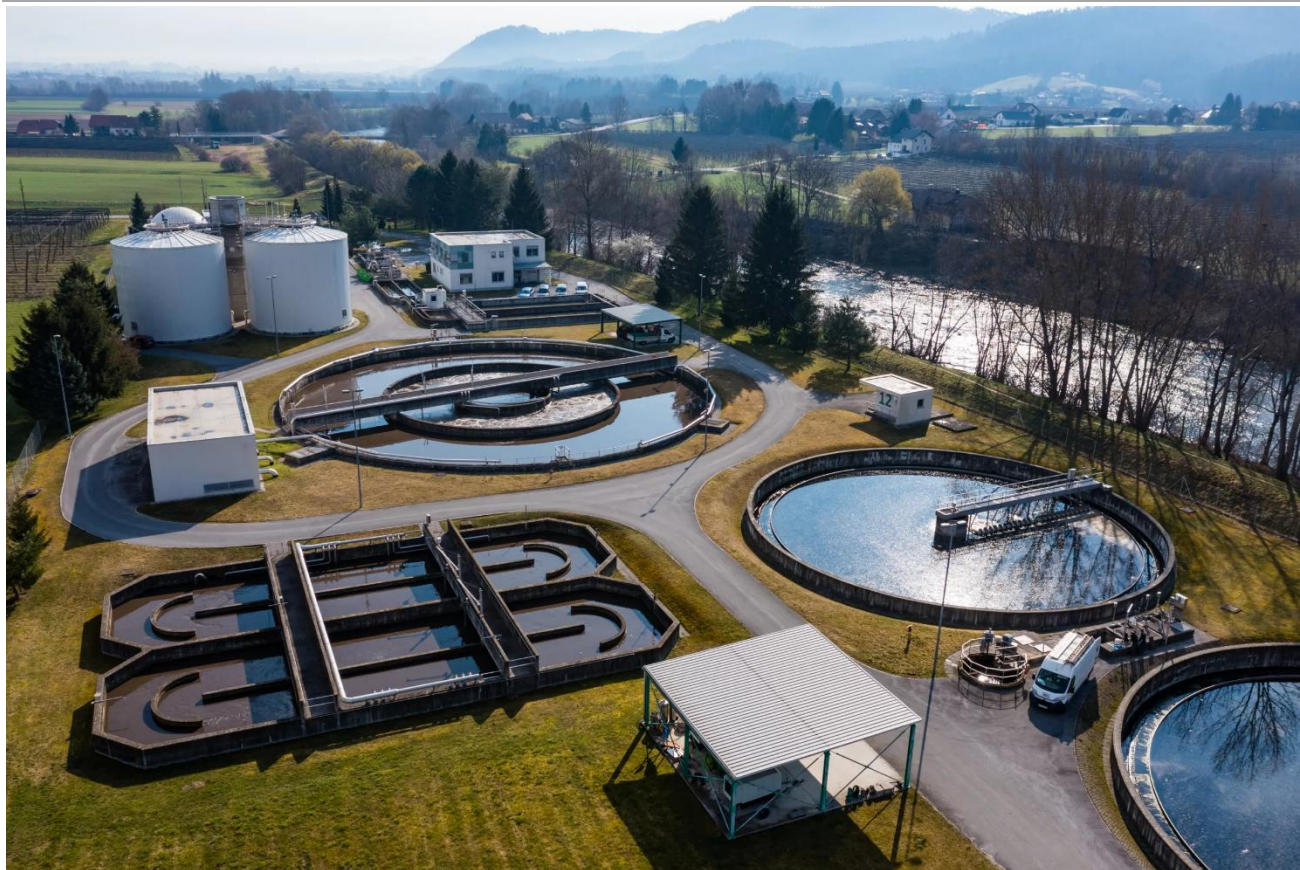
Slika 22: Centralna čistilna naprava Kasaze 61
