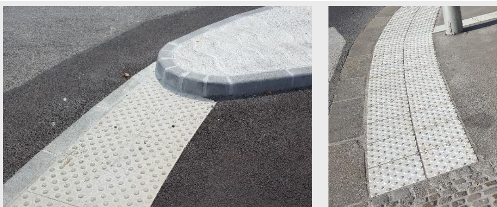
Sliki 14 (ustrezno): Primera natančne vgradnje betonskih oznak z različnima načinoma izvedbe. 1. Izvedba s predhodno vgradnjo. Taktilne oznake segajo do roba in so natančno zaključene, struktura je nepoškodovana. 2. Izvedba z rezanjem asfalta.
