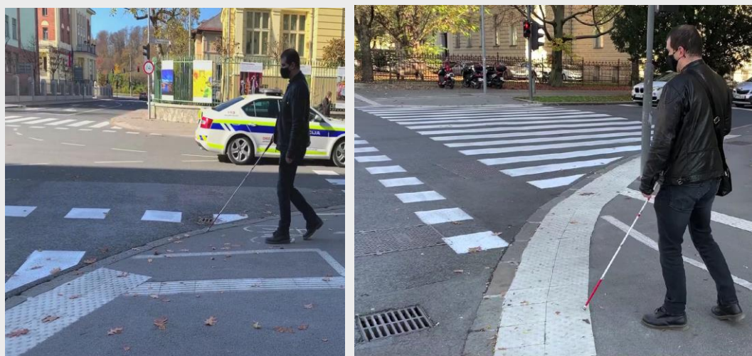
Slika 19: Taktilne oznake v križišču s poglobljenimi robniki v primeru kolesarskega pasu na pločniku. 1 (neustrezno): Na mestu kolesarskega prehoda je taktilna oznaka prekinjena, uporabnik bele palice pa je zaradi nepredvidenega dogodka izgubil orientacijo in v iskanju oprijemljivega roba zašel v križišče. 2 (ustrezno): Taktilne oznake označujejo rob ceste tudi na prehodu kolesarske steze. Uporabnik bele palice, ki je zaradi nepredvidenega dogodka izgubil orientacijo, otipa rob, po katerem lahko sledi do varne orientacijske točke (npr. semaforja).
