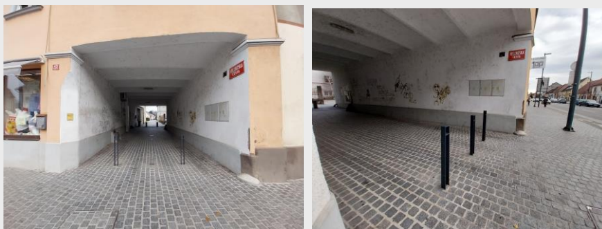
Sliki 8 (neustrezno): Primeri nezaznavnega količka. 1: V smeri hoje je količek zaradi tanke konstrukcije vizualno slabo zaznaven. 2: Z druge smeri je isti količek dobro zaznaven. Pomembno je, da je količek postavljen tako, da je viden v glavni smeri hoje. Priporočljivi so polni količki.
