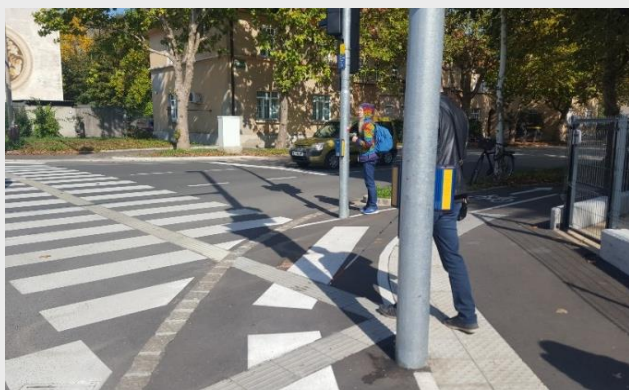
Slika 1 (neustrezno): Primer, kjer bi bilo zaradi pomanjkanja prostora nujno izvesti skupno površino za pešce in kolesarje. Kolesarski pas poteka ob cesti, talne označbe so zelo kaotične, semaforji stojijo na kolesarskem pasu, pešci ne vedo, kje je varna površina in kje lahko stojijo.
