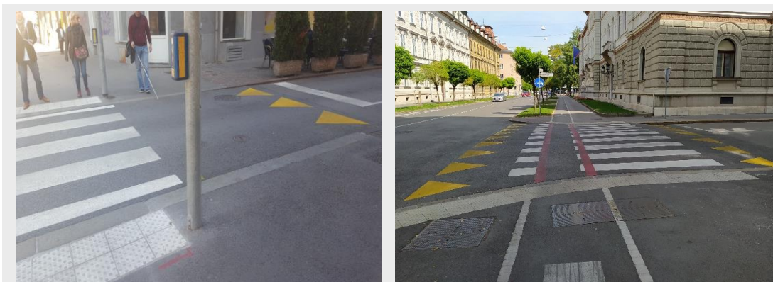
Sliki 17: Oznaki roba peščeve površine na prehodu za pešce. 1 (neustrezno): Primer nezaščitenega roba vozišča. Rob trapezne grbine je pomaknjen daleč izven prehoda za pešce, zato bi bilo treba taktilne oznake podaljšati izven prehoda za pešce do konca grbine. 2 (ustrezno): Oznaka na dvignjeni trapezni ploščadi mora segati tudi izven zebre, vse do mesta, kjer je višinska razlika med voziščem in površino za pešce že dovolj visoka, da jo lahko zaznamo s tipom (vsaj 3 cm).
