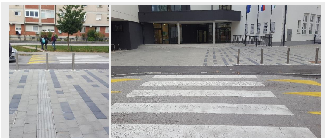
Sliki 28 (neustrezno): Primer neusklajenega načrtovanja ceste in zunanje ureditve pri šoli. 1 Taktilna vodilna linija, ki vodi do vhoda v šolo, se na drugem koncu zaključi na robu pločnika brez čepaste oznake, ki bi označevala zaključek taktilnega vodenja. Če pešec nadaljuje naprej v isti smeri, pride do prehoda za pešce (ki ni taktilno označen) in sicer izven območja zebre. Neposredno ob taktilni liniji stoji količek, v katerega se uporabnik bele palice zaleti, če hodi ob taktilni oznaki po desni strani. 2 Kontrastni vzorci v tlaku poudarjajo vhod v šolo, ki je na desni strani, vendar je takšen poudarek zavajajoč, saj ni ustrezno povezan s prehodom za pešce. Vzorci v tlaku bi v tem primeru morali usmerjati od prehoda za pešce proti vhodu, saj je ključno poudariti varno pot do šole.
