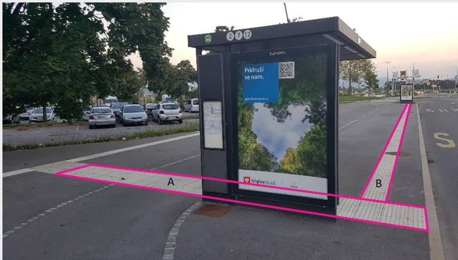
Slika 21 (ustrezno): Primer postajališča, označenega s kombinacijo standardnih oznak – del ob vstopnem mestu. Oznaka vstopnega mesta (A) je postavljena tako, da poteka neposredno ob informacijskem stebru. Taktilna vodilna linija (B) poteka vzdolž celega perona 60 cm od robnika ob cesti in se (brez čepaste oznake!) pripenja na oznako vstopnega mesta. Ta linija je pomembna zato, da pri izstopu iz avtobusa uporabnik bele palice lahko najde pot do roba pločnika.
