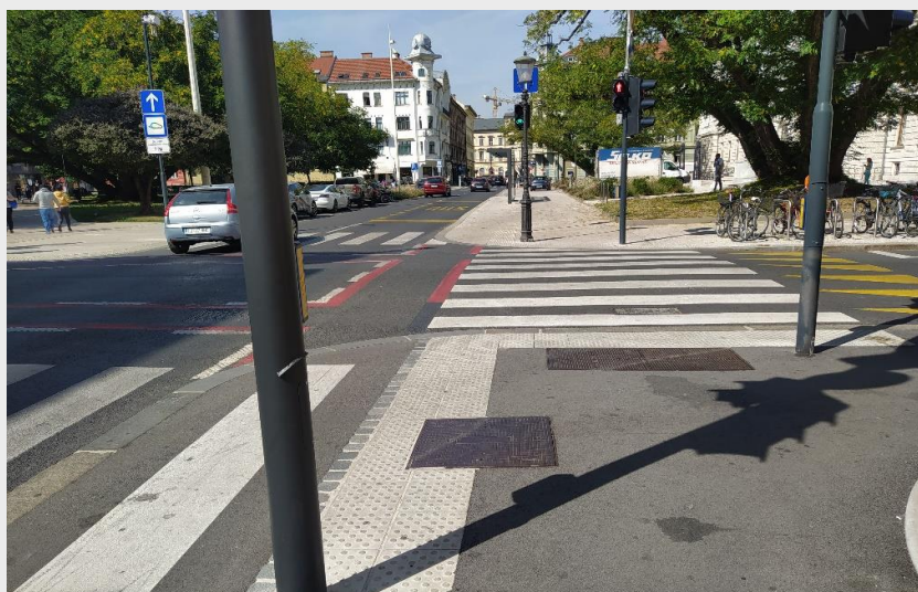
Slika 18 (ustrezno): Označitev roba varne površine s čepastimi oznakami v nivojskem križišču v primeru, ko poteka kolesarski pas ob cesti. Zvočni semafor je postavljen neposredno ob čepasti oznaki.
