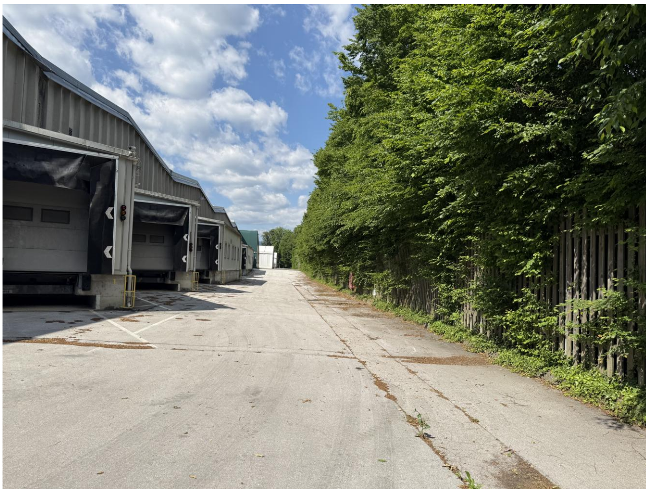
Slika 3: Pogled na območje iz vzhoda
